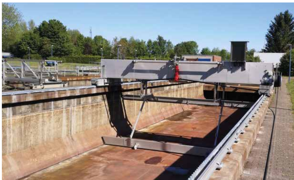
▪ HIK Längsräumer / HIK longitudinal-tank-scraper
