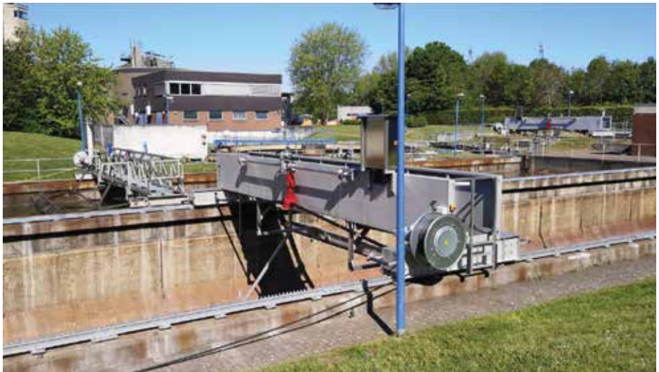
■ HIK Längsräumer / HIK longitudinal-tank-scraper
