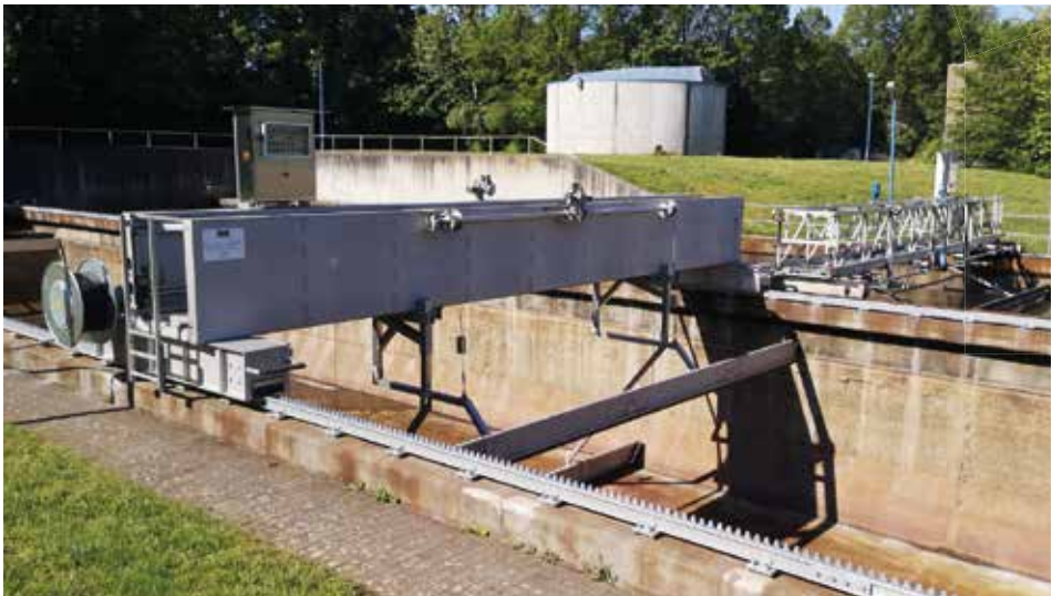
■ HIK Längsräumer / HIK longitudinal-tank-scraper
