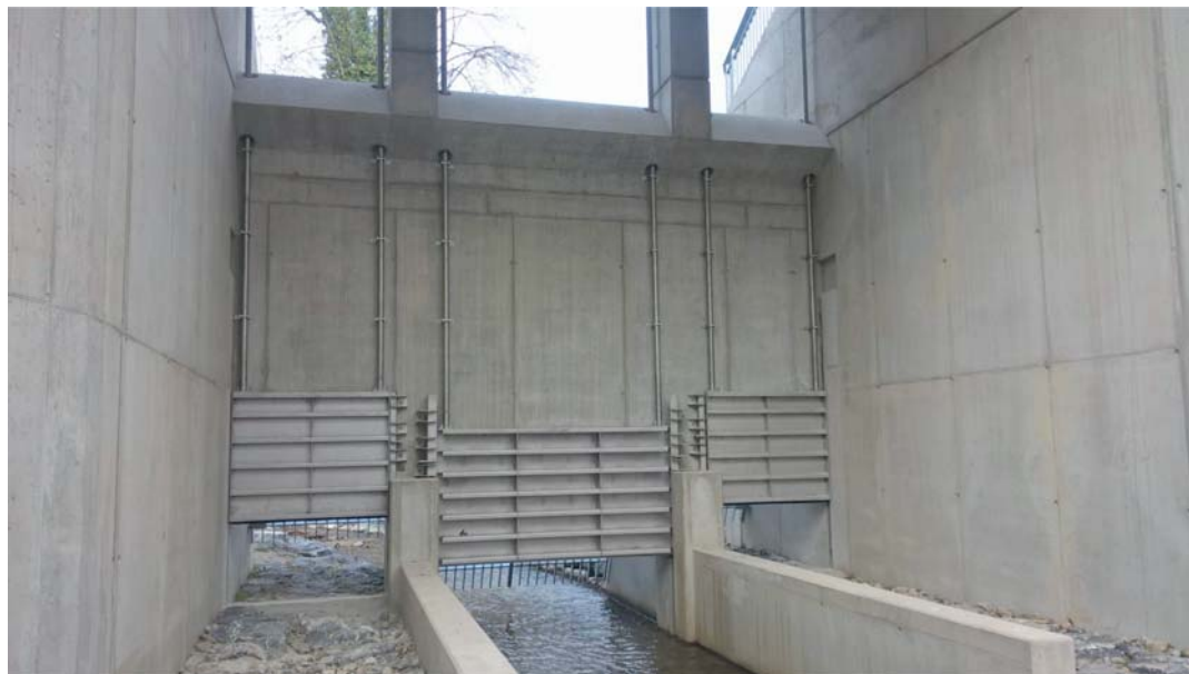
Das Bild zeigt zwei Rinnenschieber (außen), Typ GW 4R 162x135 E-W, und einen Rinnenschütz (innen), Typ GW 3R 275x140 E-W. Die doppelspindeligen Armaturen von GLA-WEL sind jeweils mit zwei Getrieben und einer elektrischen Antriebseinheit ausgerüstet. Einsatzbereich ist der Hochwasserschutz Lindau. Quelle: GLA-WEL GmbH
