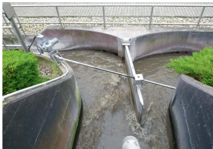
Eine Verteilerzunge ist beispielsweise eine Armatur zur Verteilung eines anströmenden Mediums aus einer Rinne in zwei weitere. Quelle: GLA-WEL GmbH
